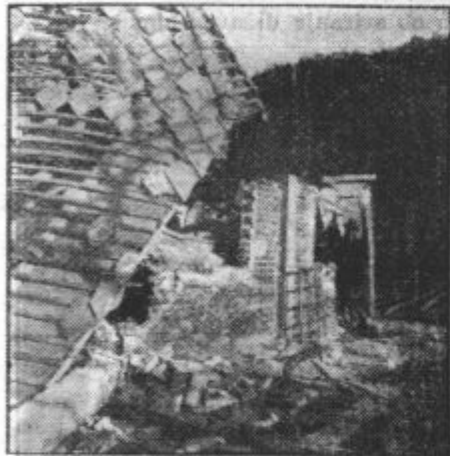
Ruševine delavnice žirovniškega kolarja Zajca. V skrbno zgradbo je bilo vzdane precej železo-betona.
