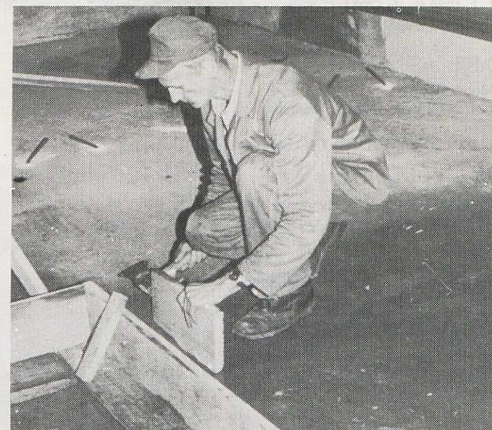
Pod višjo klimo »KIEFER« v kletnem prizidku predilnice sintetične zidarji opažujejo bazen za zajezitev vode, ki pronica iz slabo tesnjenih pločevinastih kanalov.
