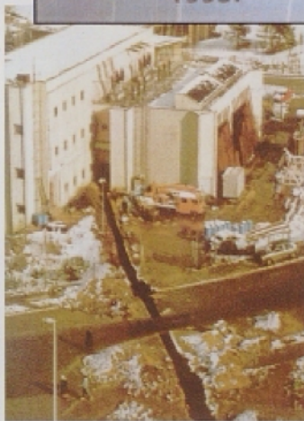
Z leve: kabel na poti v Sarajevo; struga za kabel je pripravljena; začenja se polaganje kabla. Zgoraj: napis opozarja, da je kabel darovala sarajevskim občanom Zvezna republika Nemčija leta 1995.
