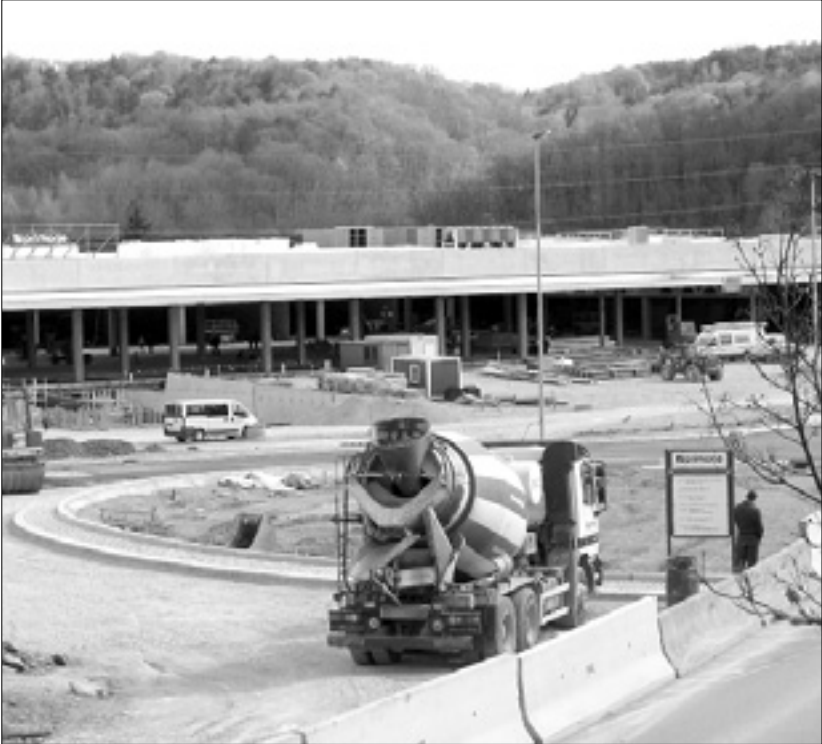
Novo krožišče gradijo s polno paro
