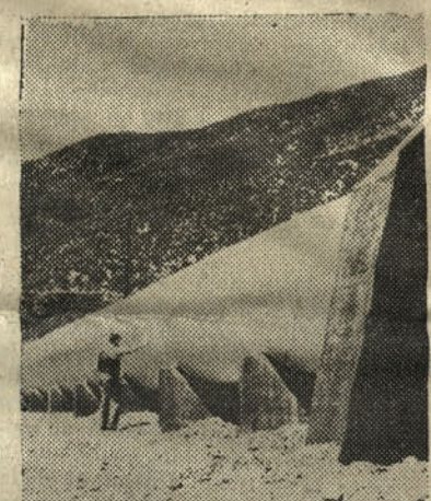
Il grande acquedotto di oltre 730 chilometri che dalla Diga Parker sul Colorado porta l'acqua ai centri della California meridionale provvedendo al rifornimento idrico di 28 città
