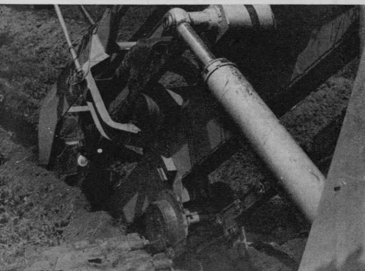
Sl. 2. Izkop kablskega jarka
