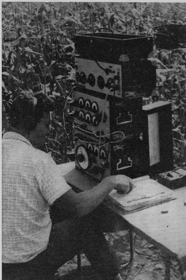
Sl. 1. Kapacitivna izravnava medkrajevnega kabla
