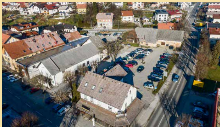
Območje izgradnje Kulturno-upravnega centra Ivančna Gorica
