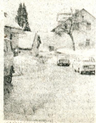
Asfaltirali so središče Javorij.
