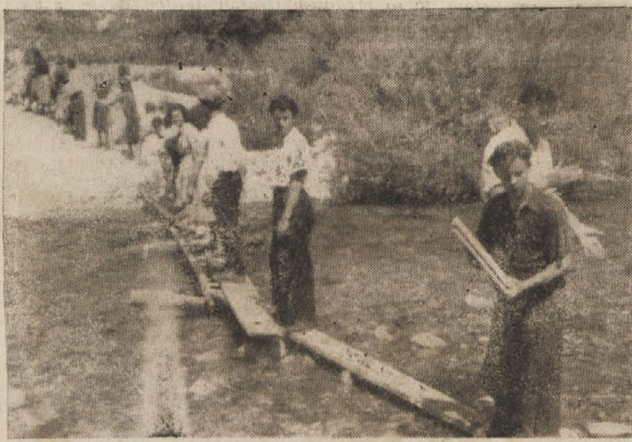
Tako je šel gradbeni material na Grahovo iz roke v roko
