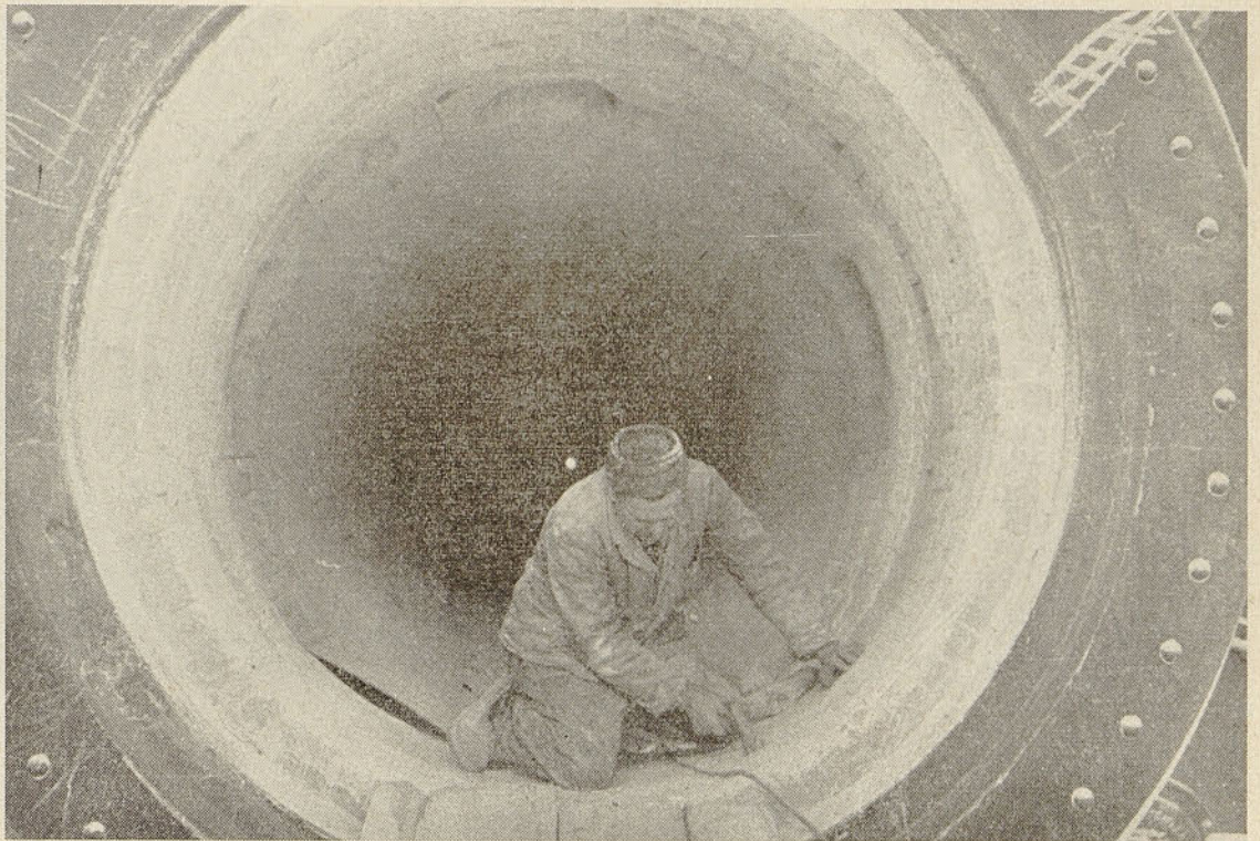
Remont rotacijske peči
