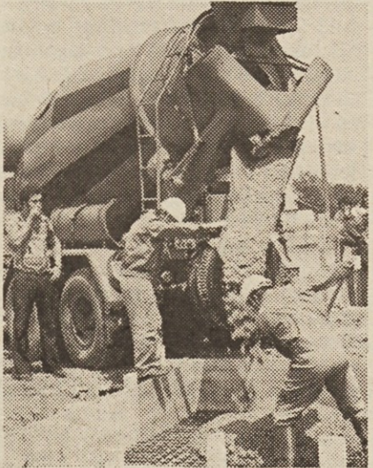
Vsul se je prvi beton.
