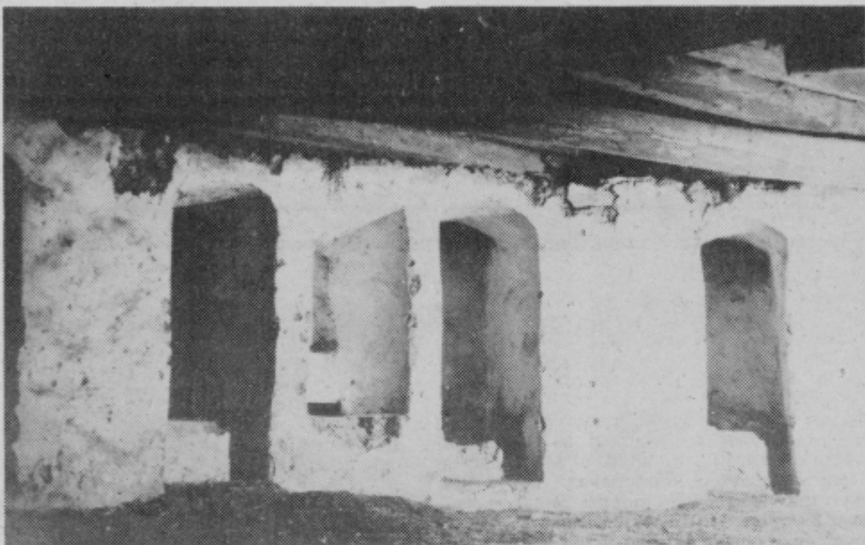
Niše s strelnicami in izlivnicami za smolo v vrhnjem delu obrambnega stolpa na velenjskem gradu
