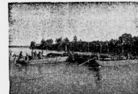
Člen mosta se pomika na svoj prostor. Dobro se vidi motorni čoln, ki potiska.
