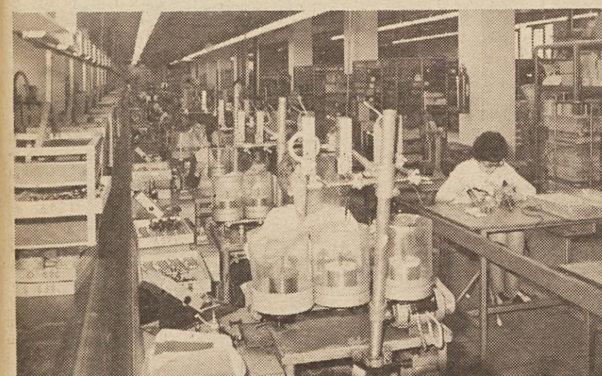
Linija v navijalnici tuljavic za ploščate releje.
