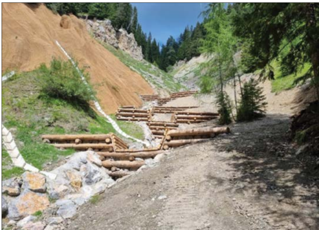
Slika 4: Sanacija erozijskega žarišča Jurež v občini Kranjska Gora (arhiv APUS d. o. o.)
