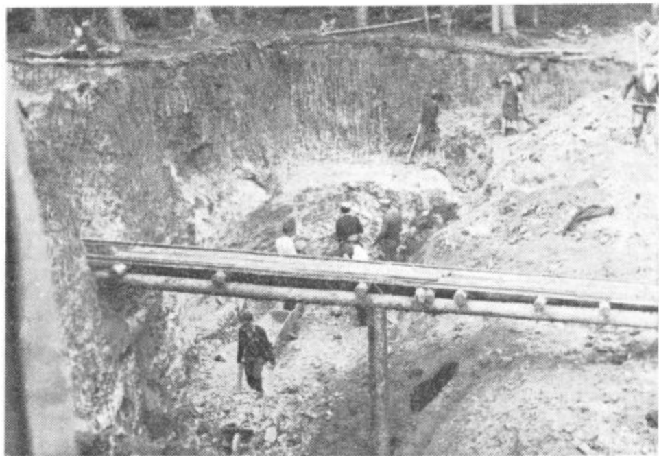
Zaloška gorica: Ročni odkop bentonita (1958)
