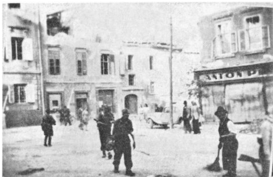
Porušene stavbe na današnjem Trgu svobode
