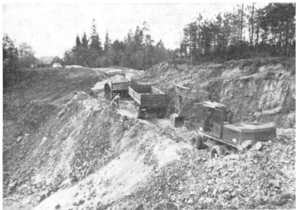
Dnevni kop Zaloška gorica. Odkop bentonita
