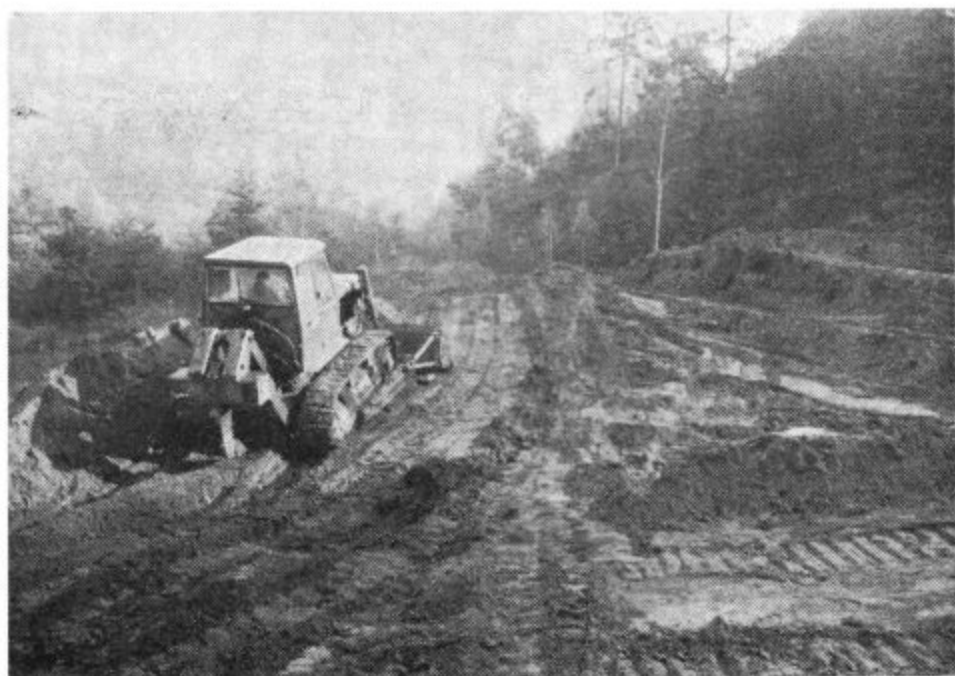
Peskopop Vrhe. Pripravljalna dela za odkop kremenovega peska
