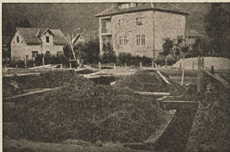
Pogled na gradbišče nove pošte v Kočevju. Pod streho bo že letos, dokončno pa bo urejena verjetno do oktobra 1963
