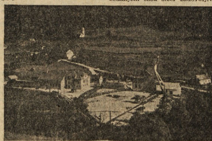
Rudnik Zagorje — strojni jašek obrata Kisovec
