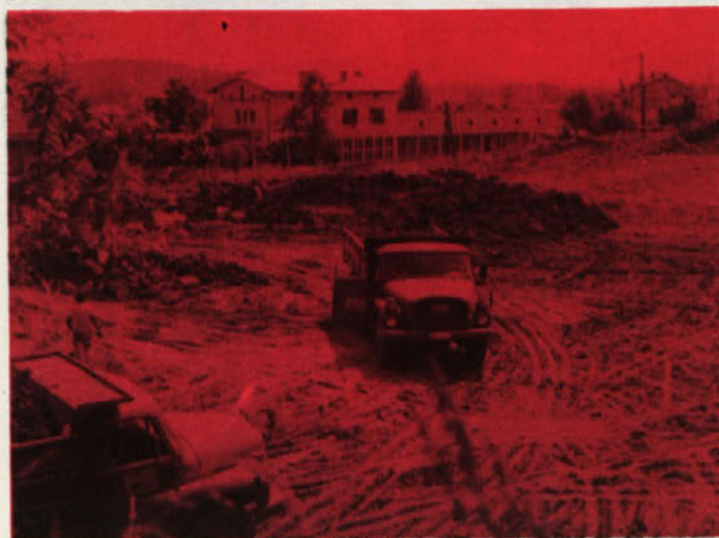
GRADNJA NOVE KODRANKE – Končno so se začele nekajletne želje tudi uresničevati. Na sliki: novo gradbišče
