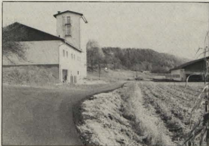
To cesto k podjetju GEPI je STUAG asfaltirala zastoni.
