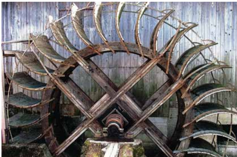
Slika 7: V Polžah pri Novi Cerkvi je ohranjena in vzorno vzdrževana Sorževa žaga iz leta 1872.
