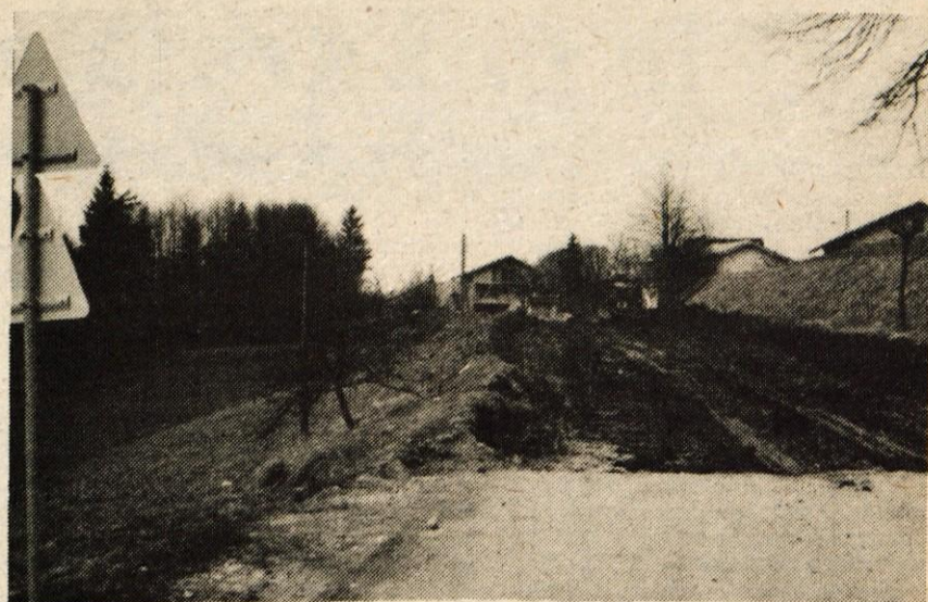
KMALU KONEC MAKADAMA – Delavci komunalnega podjetja iz Ljubljane so pričeli z rekonstrukcijo ceste Vikrče–Smlednik. V prvi fazi bodo uredili 650 m dolge odseke ceste, sledila bo rekonstrukcija ceste v Smledniku in končno še asfaltiranje celotne trase.
