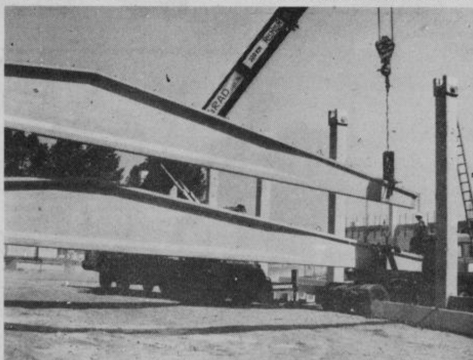
Gradnja industrijskega objekta z elementi lastnega montažnega sistema Ingrad. Vse armiranobetonske elemente izdelajo v tozid IGM Medlog, montažo po gradbiščih Jugoslavije in tujine pa opravljajo delavci tozida Gradbena operativa Szentjur.
