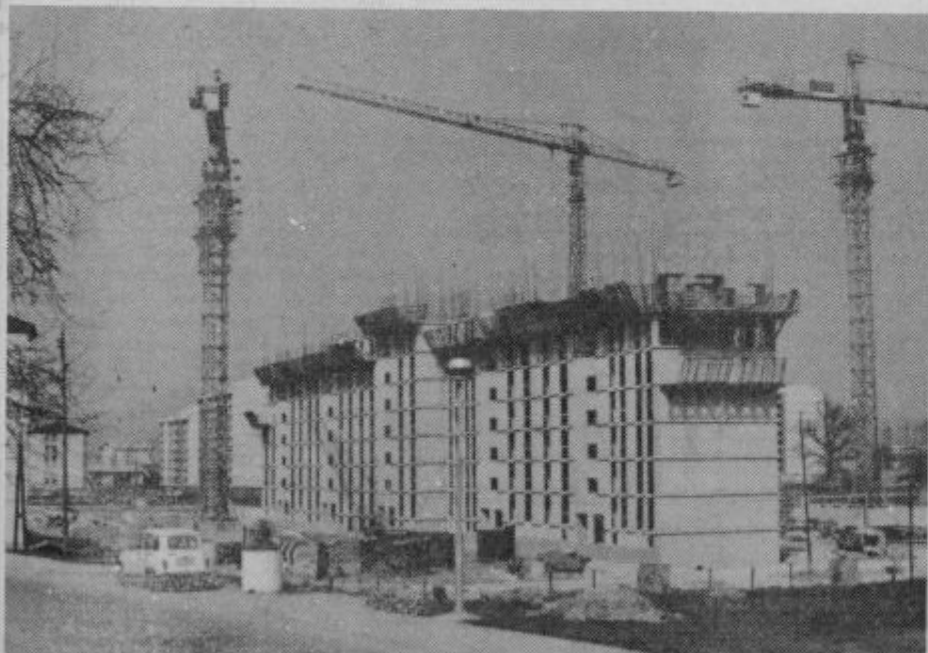
V celjski občini Ingrad že gradi stanovanjske soseske po novi tehnologiji - s prilagodljivimi stanovanji. Prvi objekti so že oddani investitorju in stanovalcem, ki so z velikim zadovoljstvom sprejeli nova stanovanja, saj jim nov način gradnje nudi možnost spreminjanja strukture stanovanj še med in tudi po končani gradnji. Na sliki gradnja soseske na Spodnji Hudinji.
