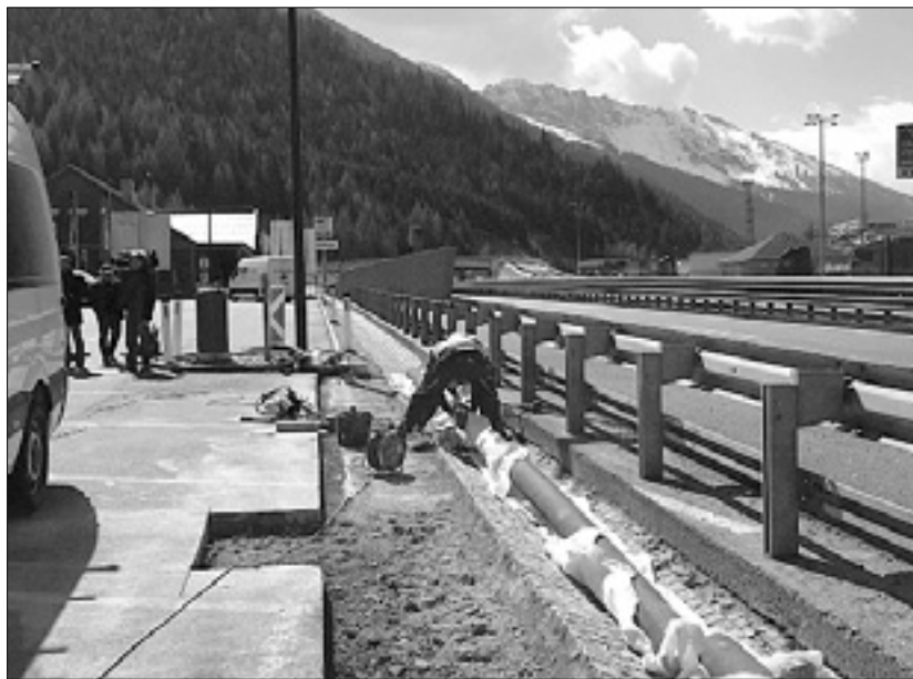
Dela za namestitev pregrade proti beguncem na Brennerju
