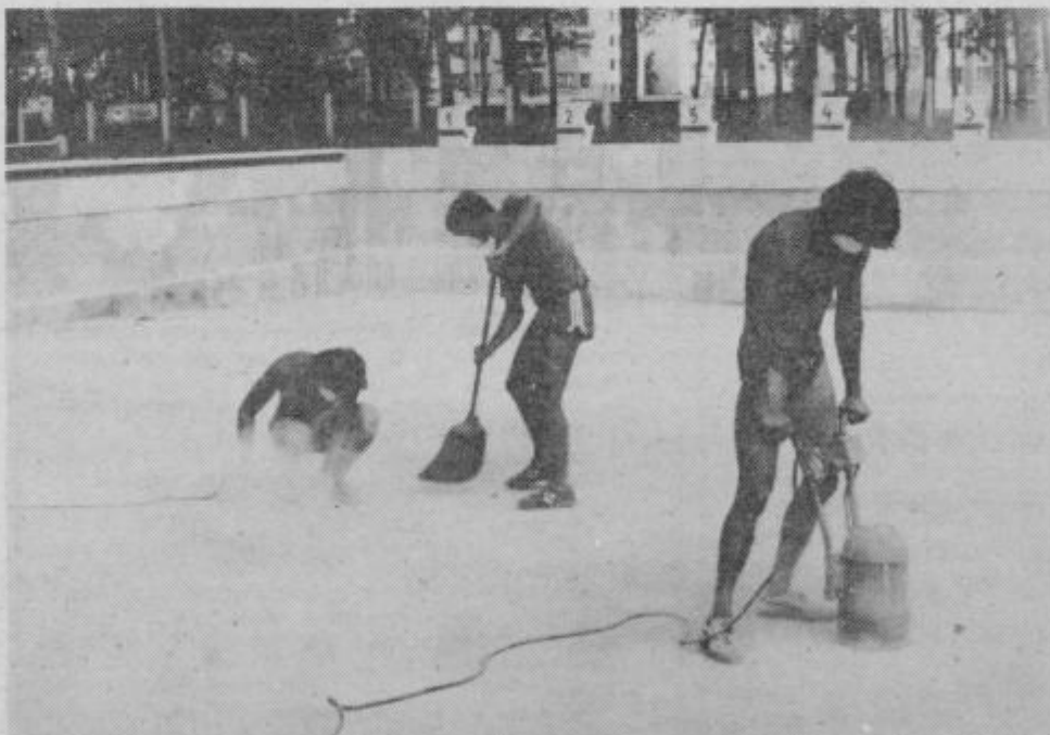
Naporno delo pri prenavljanju šentjurskega kopalnega bazena. Na sliki so alpinisti Bojan Srot, Andrej Primožič in Aleš Stopar, ki brusijo dno bazena.
