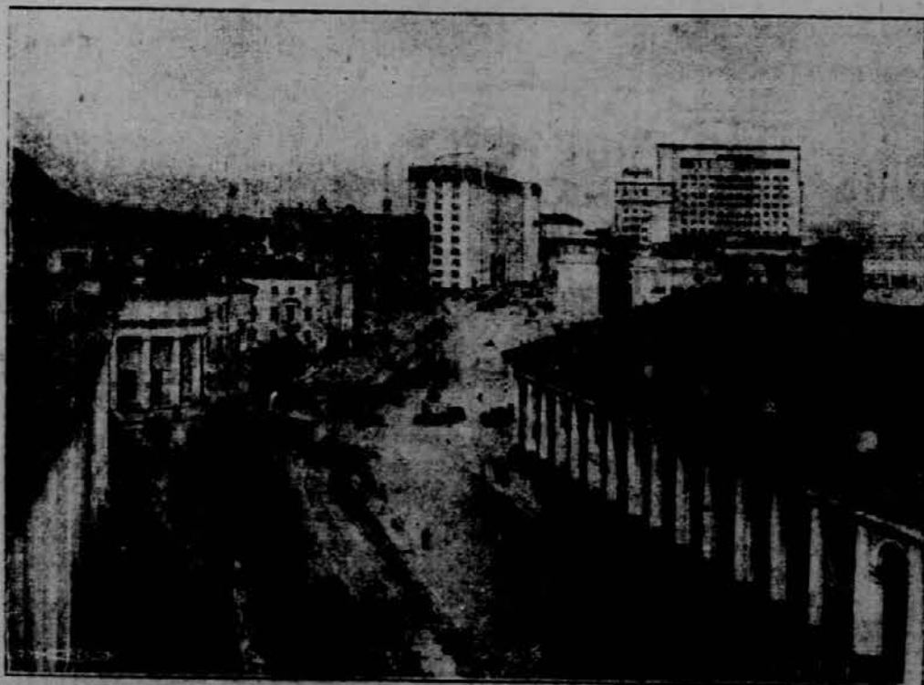
Pogled na moderno cesto, ki vodi proti Palačam sorjetov, ki so zgrajene po amer. uzorcu.
