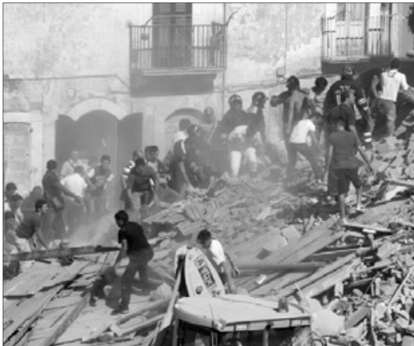
Reševalci na ruševinah stavbe
