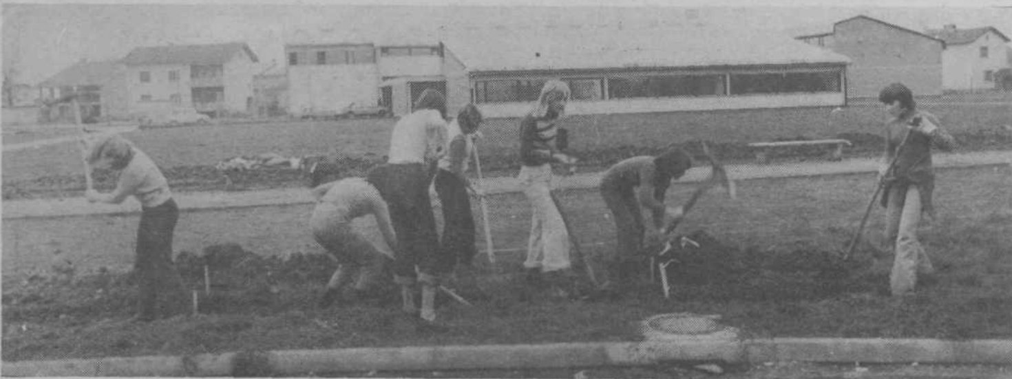
V začetku decembra so učenci osmega razreda OŠ Adolfa Jakhla pomagali urejati okolico šole. Več popoldnevov so okrog šole kopali jarke, v katere bodo kasneje delavci podjetja Rast posadili drevesa in okrasne grmiče. (Foto: Fotokrožek OŠ Adolfa Jakhla - Zalog)
