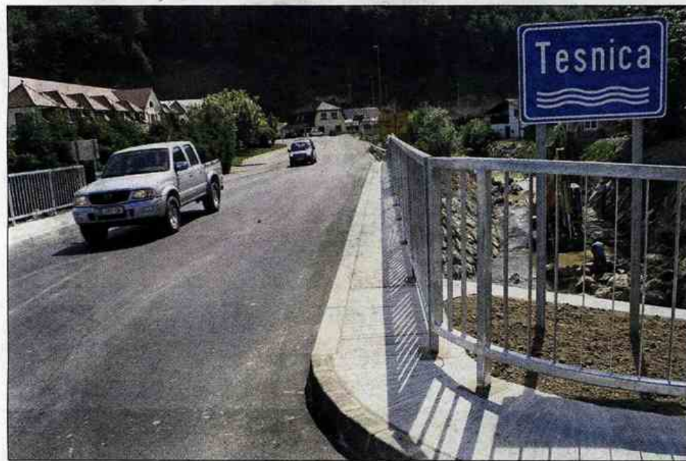
Po dveh letih je nov most v Višnji vasi končno zgrajen in odprt za promet. Ob gradnji mostu so uredili tudi strugo potoka Tesnica.
