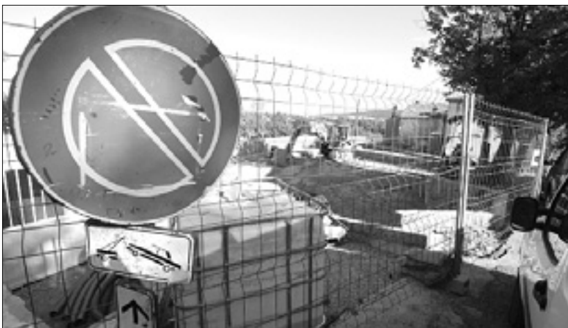
Parkirišče na Kontovelu: dela že več tednov ustavljena
