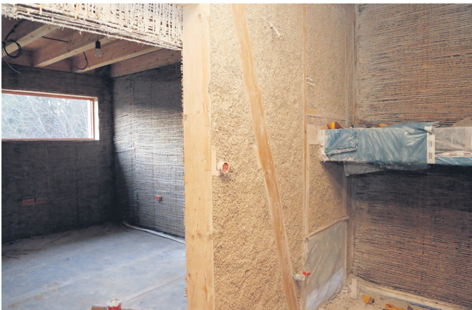
Notranji ometi bodo iz naravne glin, zunanja fasada bo kombinacija kamna, apna in macesnovega lesa.
