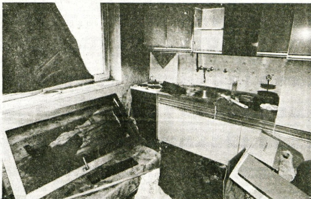
Ožgani zidovi, pogorela oprema - najmanj za 15 milijonov škode v jeseniškem bloku, kjer je pogorelo sedem stanovanj.
