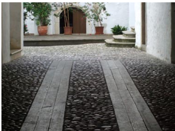
■ Slika 5. Grad Podsreda. V prehodni veži so po dolžini položeni hrastovi plohi, drugo je zapolnjeno s t. i. mačjimi glavami (arhiv Kozjanski park, 2008).
