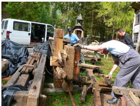
■ Slika 9. Demontaža križnega jarma iz žagalnega mehanizma „Rožančeve“ žage
