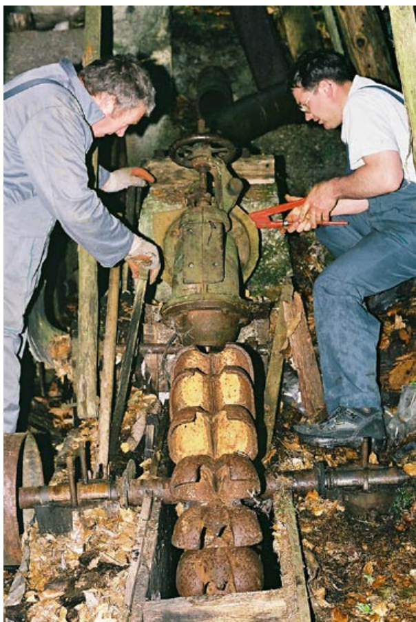
■ Slika 7. Demontaža Peltonove turbine vodne žage v Srednjem vrhu nad Gozd Martuljkom
