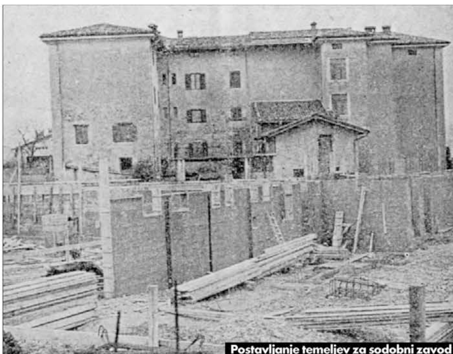
Postavljanje temeljev za sodobni zavod
