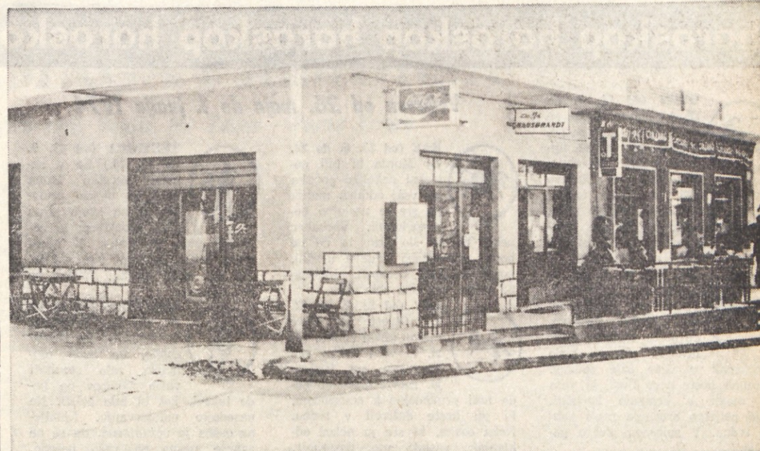
Buldozerji grozijo tudi Gregoretijevi stavbi: v njej so stanovanja, poslovni prostori in javni lokali
