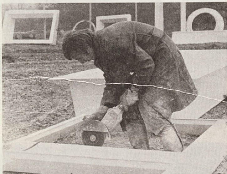
Posnetek prikazuje zaključna dela na podnožju svetlobne kupole. (foto: V. Kastelic)
