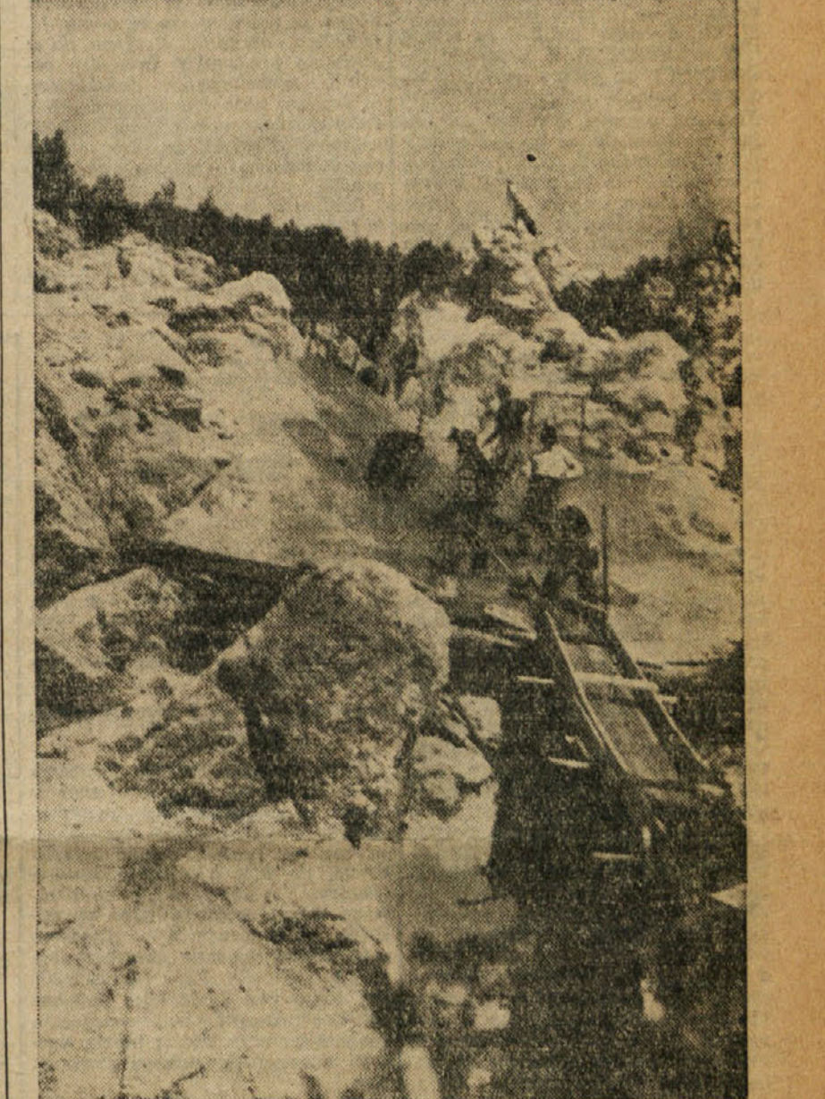
V kamnolomu so ves dan na delu in pripravljajo kamenje in pesek ter ga spravljajo na gradilišče
