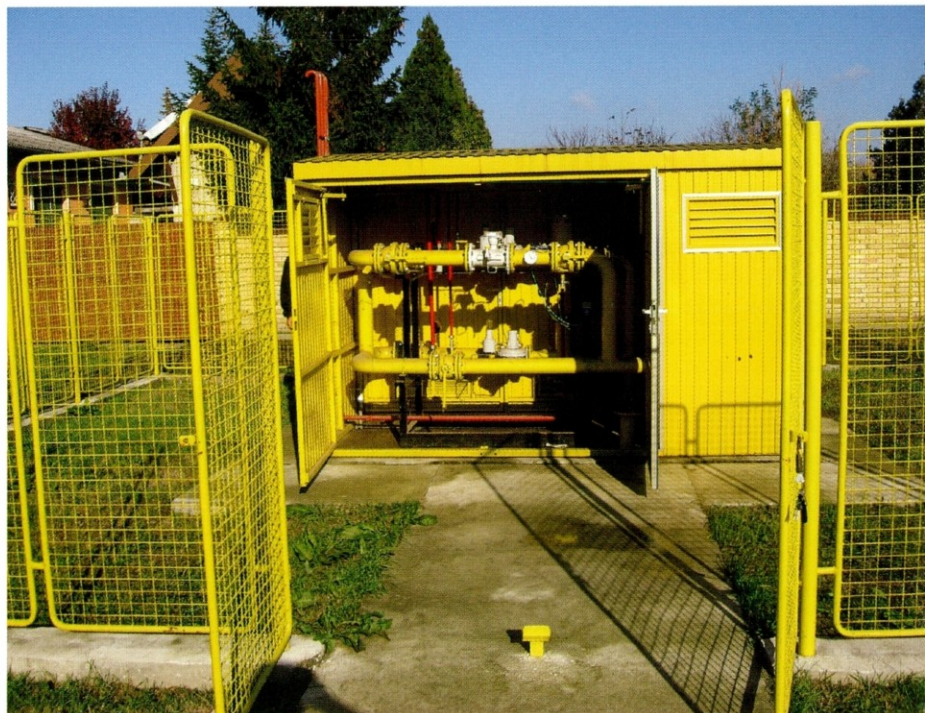
MRS široke potrošnje sa odorizatorom, kapaciteta 2.400 Sm 3 /sat
