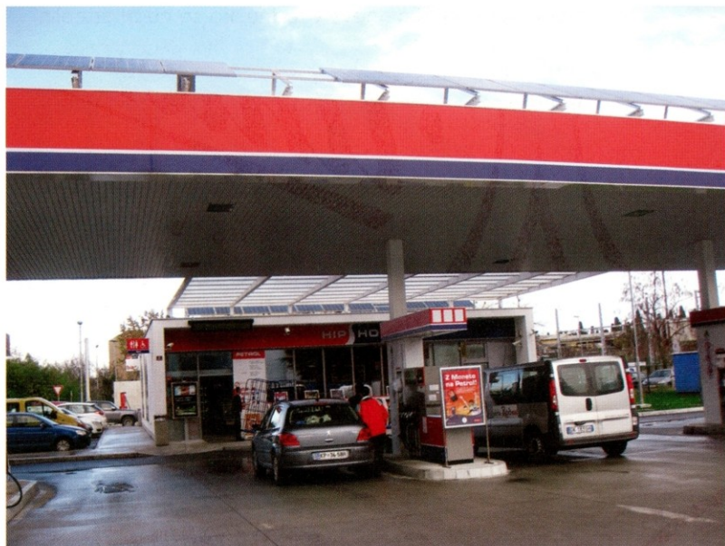
"Elektrika" na strehi bencinskega servisa
