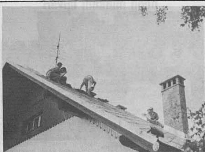
V vzdrževanje doma na Goropekah sodi tudi popravilo strehe
