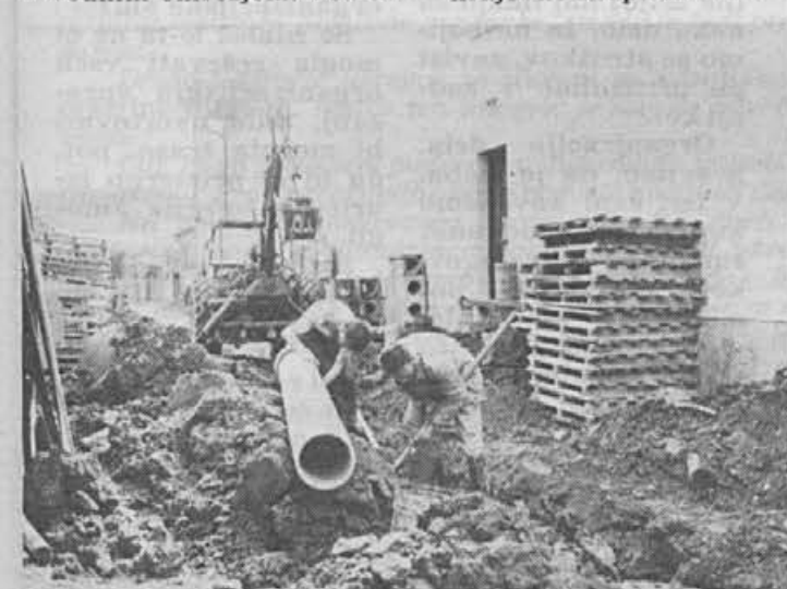
Delavci Remont-gradenj sodelujejo pri izgradnji kanalizacijskega omrežja
