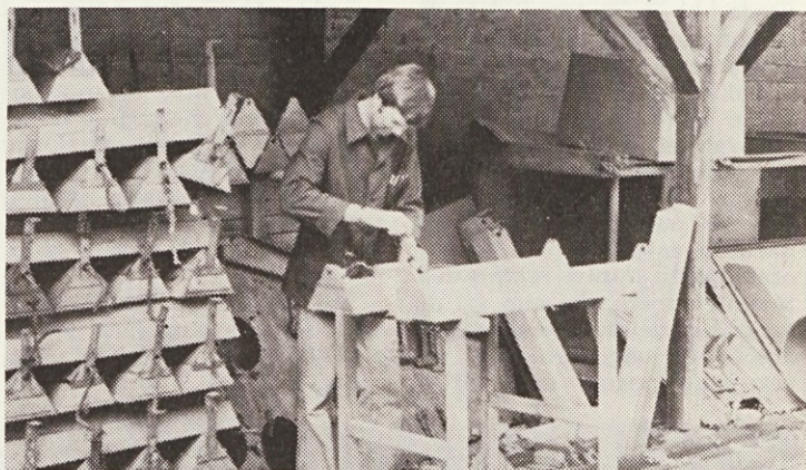
Jože Vizlar marljivo popravlja stare svetilke. Zamenjati je potrebno obrabljene dele, postrgati rjo in jih popleskati. Namestili jih bodo v predilnici III.
