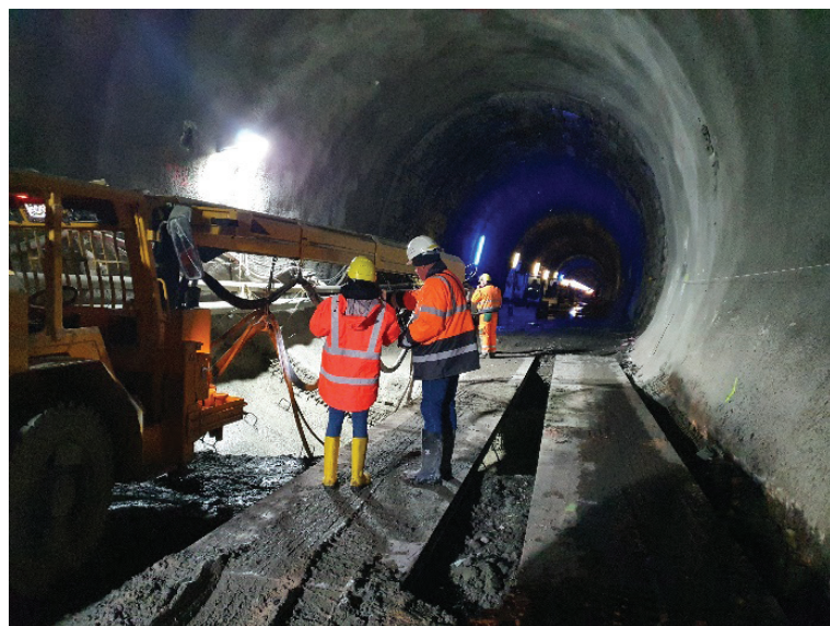
Slika 2 • Izvedba sanacije oboka predora z armaturno mrežo in brizganim (torkret) betonom. Foto: arhiv Direkcije RS za infrastrukturo
