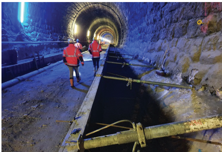
Slika 3 • Opaž za izvedbo drenažnega betona. Na drenažni beton se nato izvedejo betonske koritnice za kable in betonski hodnik. Foto: arhiv Direkcije RS za infrastrukturo
