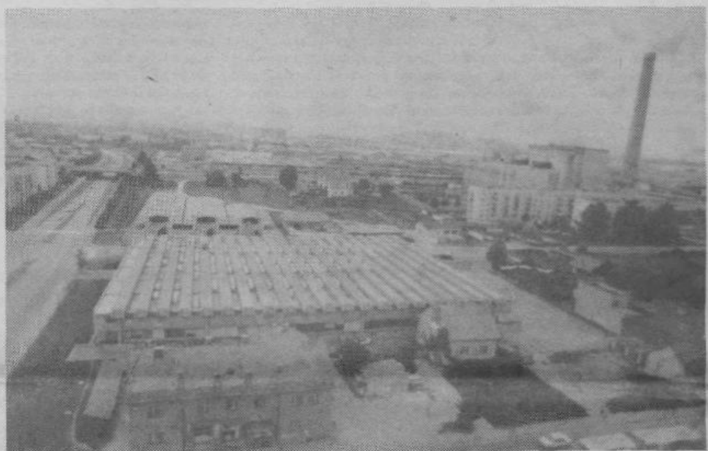
Nova tiskarna Jožeta Moškriča že leto dni dela s polnimi močmi, Toplarna pa za skoraj dve leti kasni z gradnjo II. faze 50 MW turboagregata (foto: Dušan)
