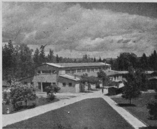
Pogled na severni del tovarne
