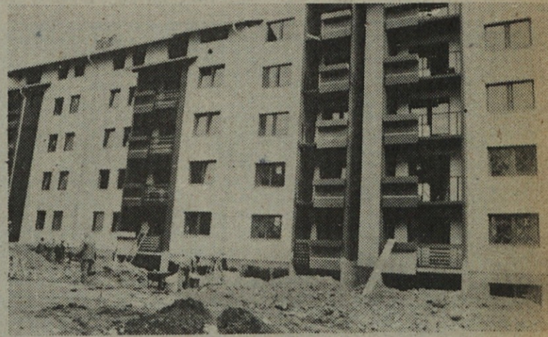
V zaključni fazi je adaptacija stanovanjsko-poslovne stavbe Kmetijske za druge Ravne
