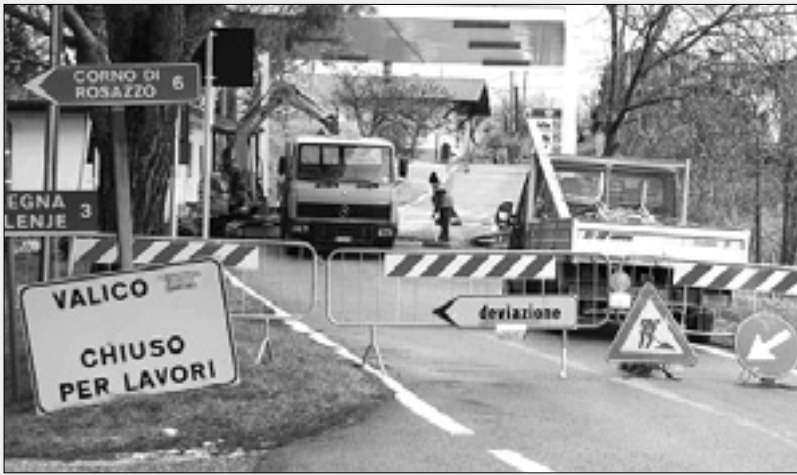
Gradbišče na meji pri Plešivem
