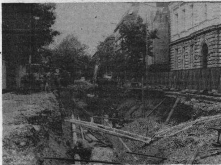
Potem ko bodo zasuli tole jamo, bo pod Resljevo cesto tekla vroča voda
