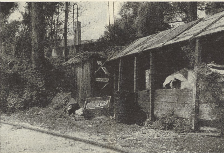
»Novo« skladišče pri stranskem vratarju v Janeziji, ki ga je bilo nujno potrebno zgraditi
