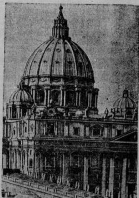
Kupola sv. Petra popravljena. Pred tremi leti so opazili na kupoli sv. Petra v Rimu velike razpoke. Papež je takoj odredil vse potrebne popravke, ki so jih sedaj dovršili. Velike kamene so nadomestili z novimi, razpoke so zalili z železo-betonom. V spomin velikih poprav so vrezali v kamen ime sedanjega papeža in letnice.
