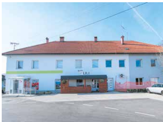
Obnova zunanosti objekta Kulturnega doma in Kmetijske zadruge na Muljavi
