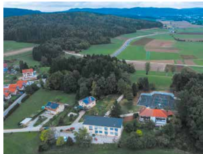
Obnova večnamenskega športnega igrišča na Muljavi
