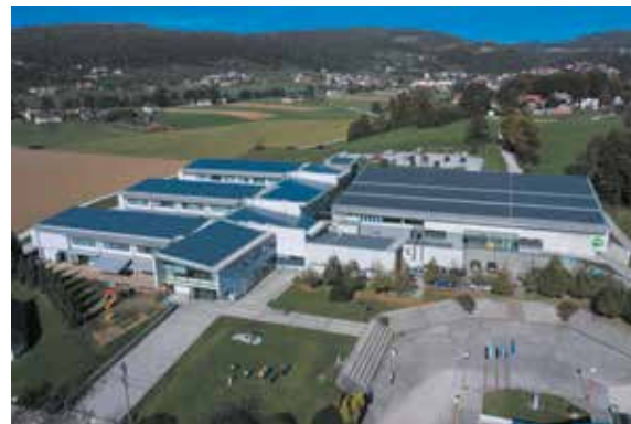
Sončna elektrarna na strehi Osnovne šole Stična
