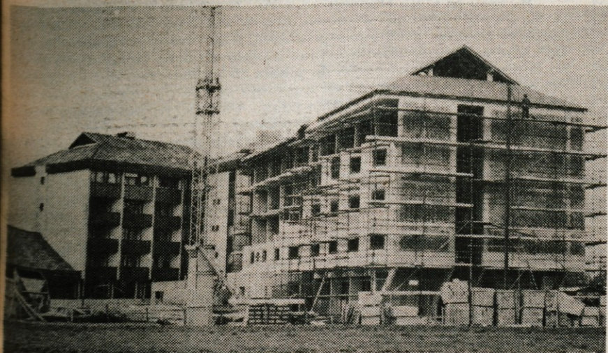
Dom upokojevcev širijo — Že jeseni so pri domu upokojevcev dr. Janka Benedika v Radovljici, ki se je zadnje leto otepal z vse večjo prostorsko stisko, začeli graditi prizidek. Z njim bodo domske zmožnosti povečali za 80 novih ležišč, v prizidku pa bo prostora tudi za nekatere skupne prostore, ki so jih v starem domu pogrešali. — Foto: F. Perdan
